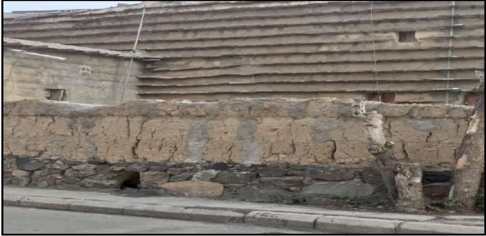
صوره (4) صيانة المبنى باستخدام مادة الاسمنت والبلوك مما أدى الى تشويه للمبنى الدراسة الميدانية 1441/12/12
