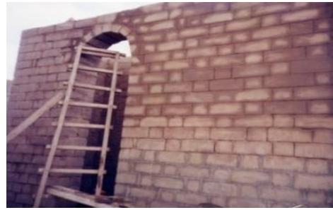
شكل - ٧. شكل الطوب المضغوط المثبت بالإسمنت وطريقة البناء به كجدران حاملة.
